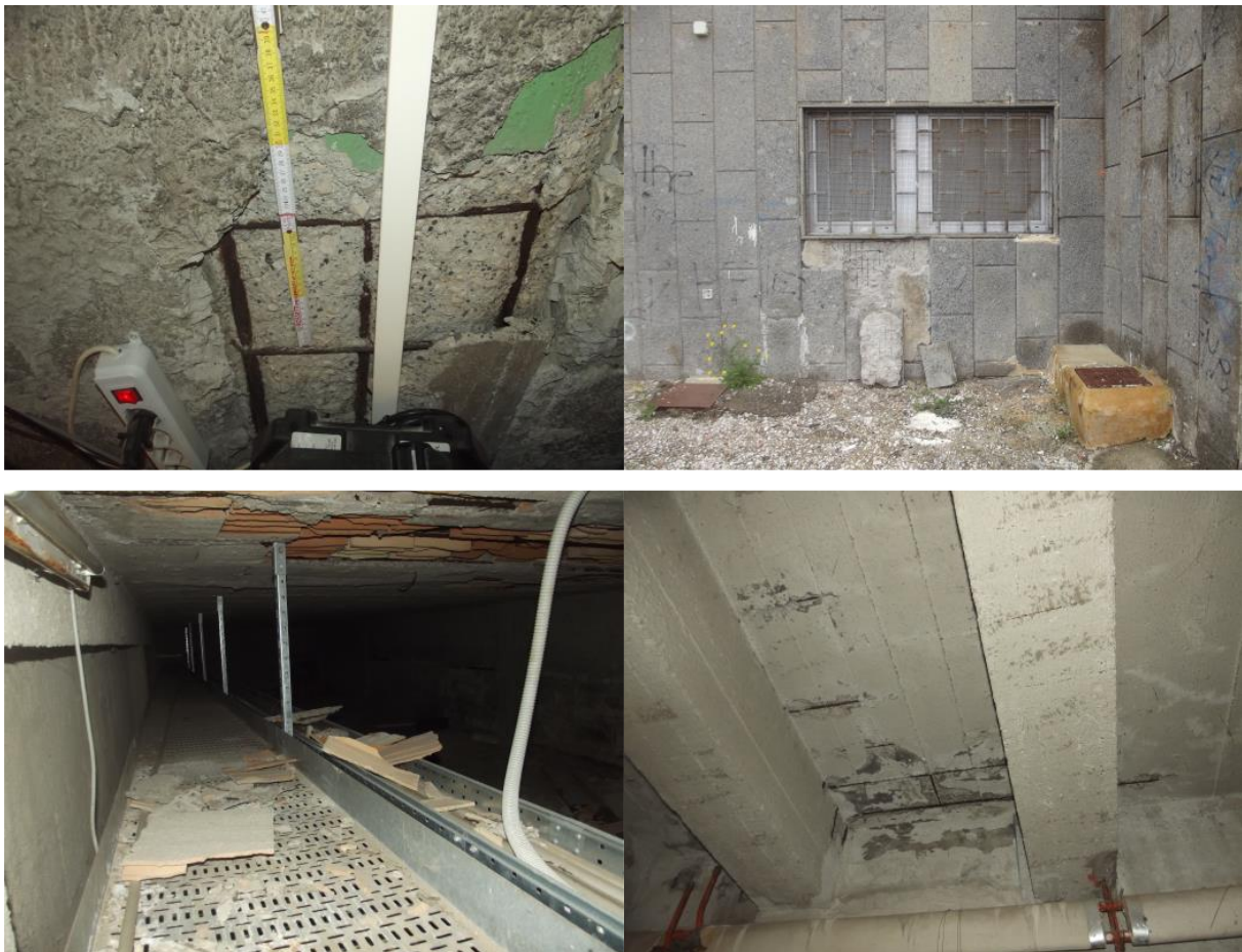
Dettagli degli elementi strutturali
