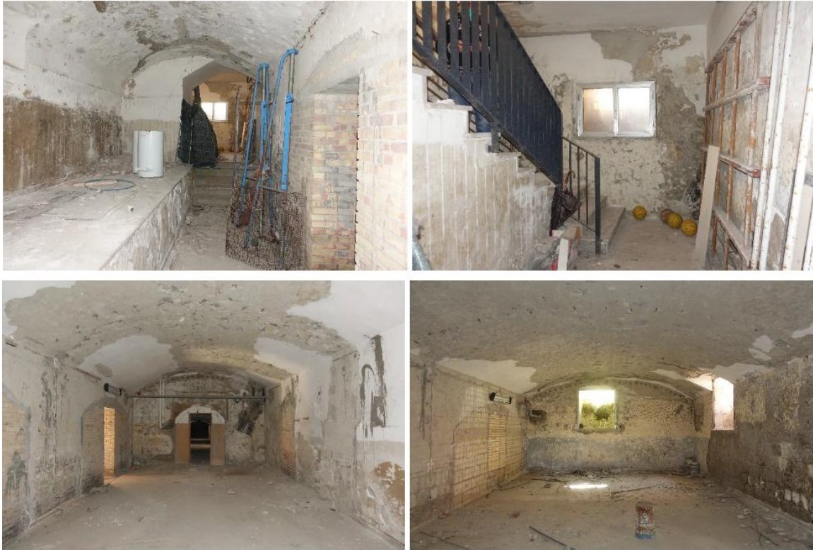
Dettagli degli elementi strutturali
