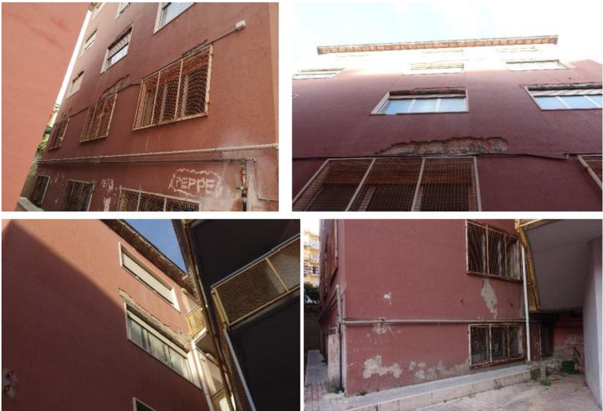
Dettagli degli elementi strutturali
