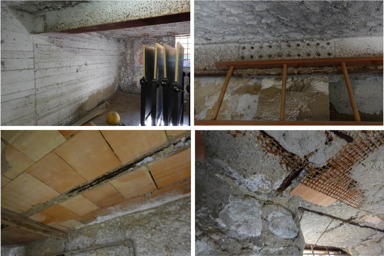
Dettagli degli elementi strutturali
