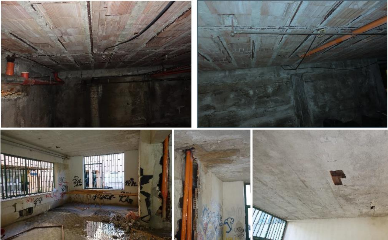
Dettagli degli elementi strutturali
