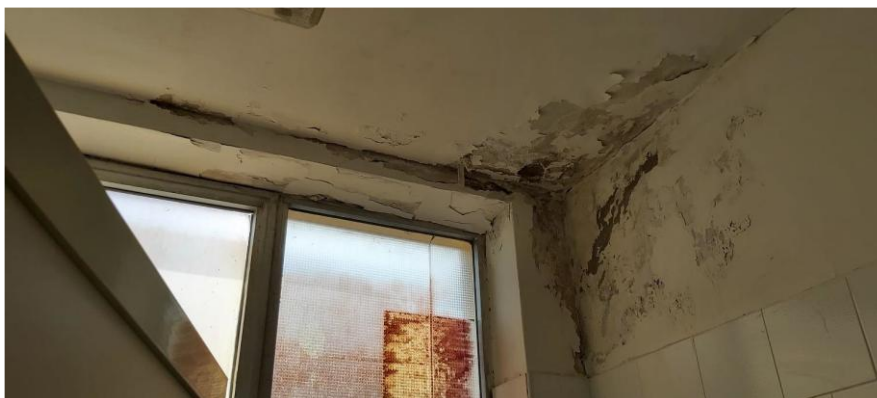
Dettagli degli elementi strutturali
