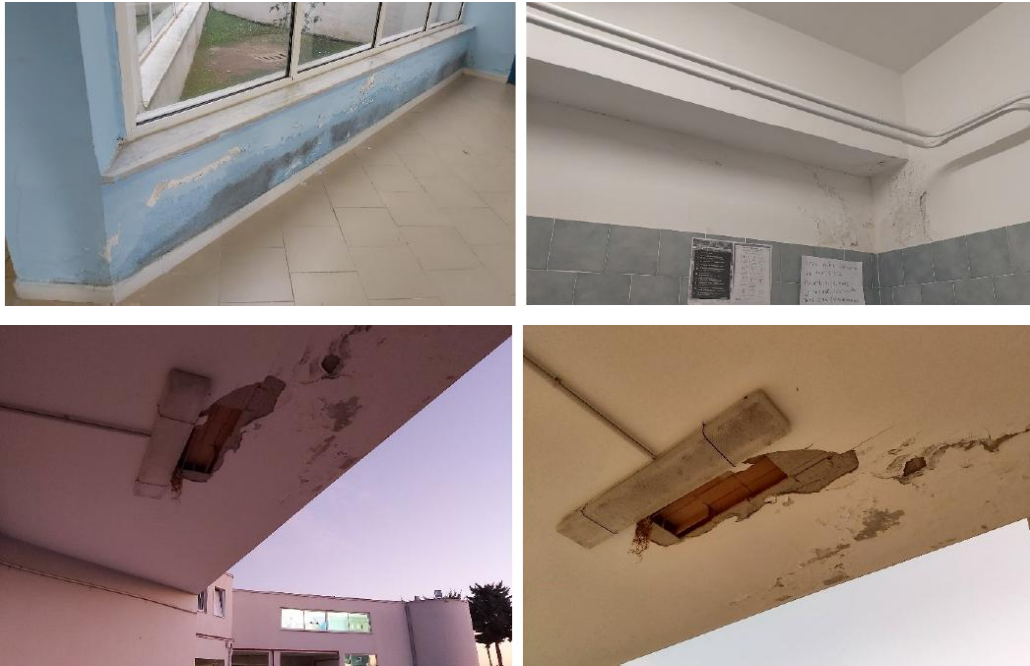
Dettagli degli elementi strutturali
