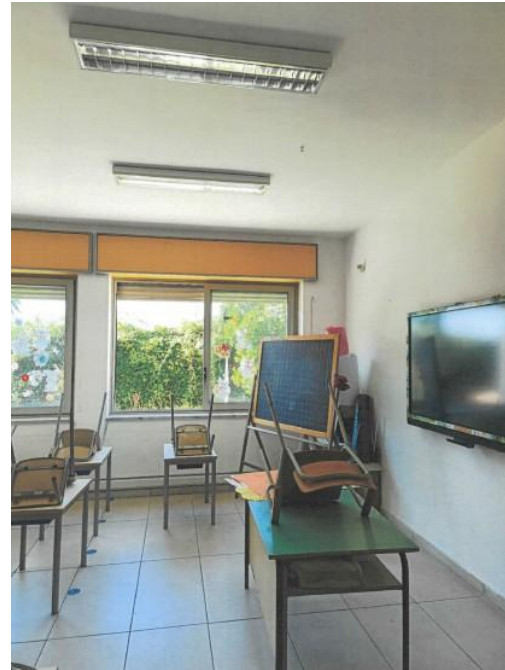
Dettagli dello stato della struttura
