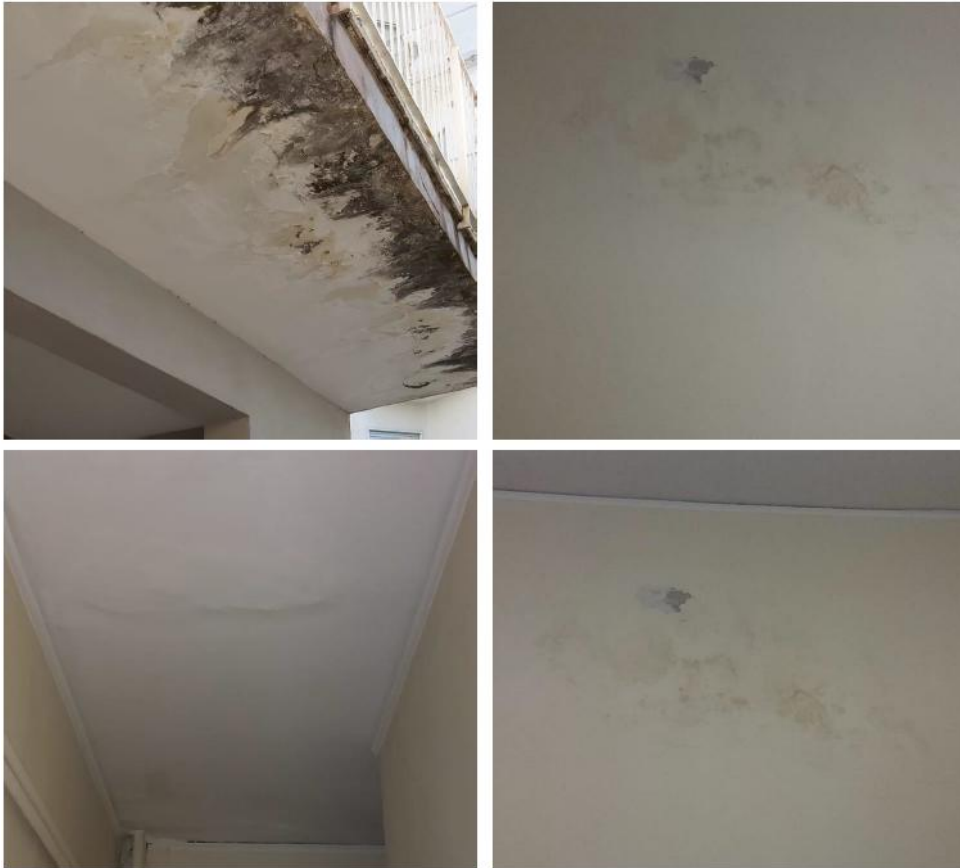
Dettagli degli elementi strutturali
