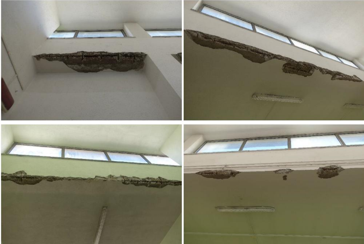
Dettagli degli elementi strutturali
