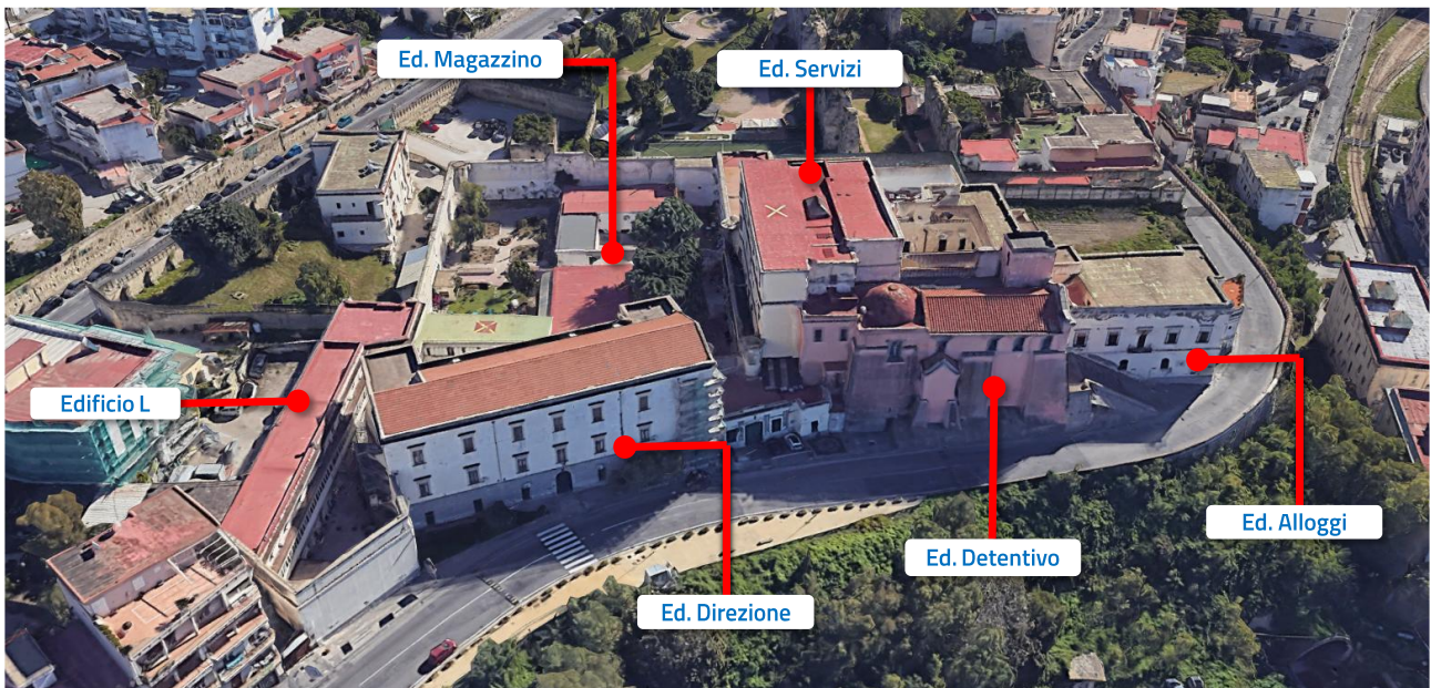
Vista d'insieme del complesso edilizio della Casa Circondariale
