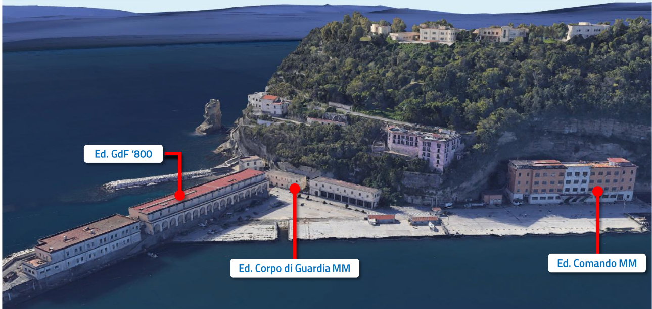
Vista d'insieme del complesso militare di Nisida
