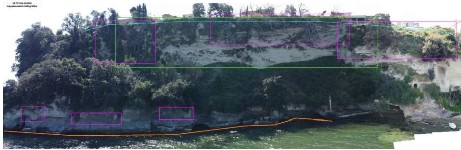
Settore Nord - interventi in parete e al piede
