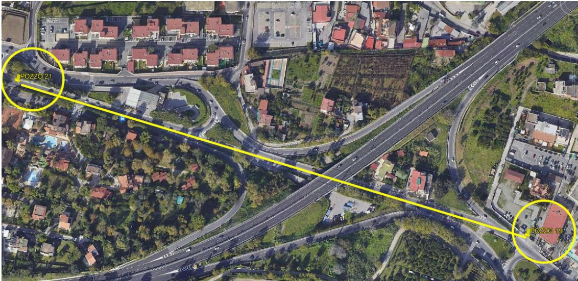
Tratto 2 - tra i pozzi di accesso 19 e 21 (Collettore di Cuma)
