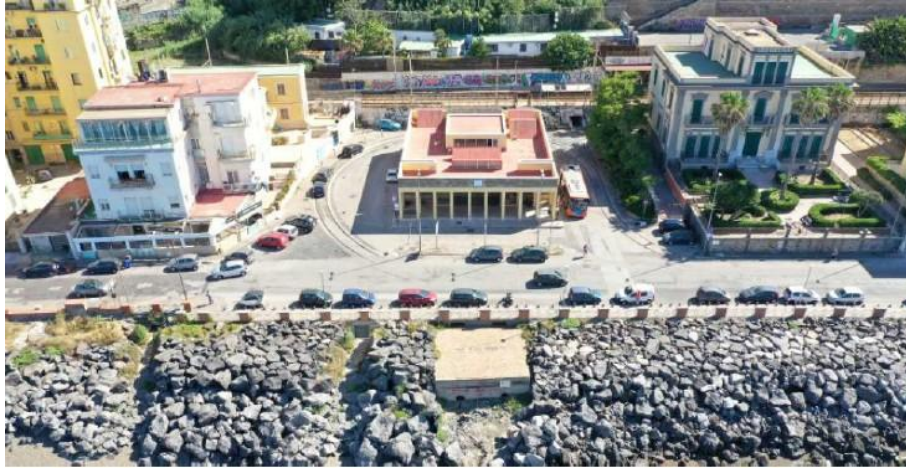
Sbocco a mare della galleria emissario
