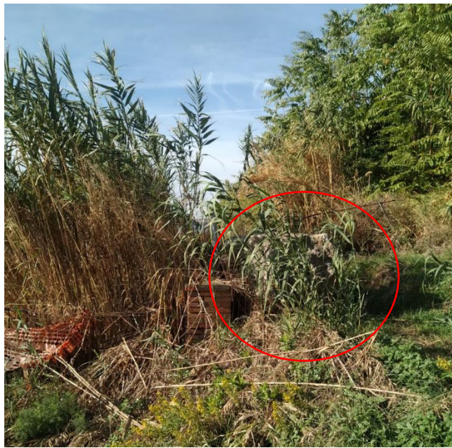
Ammasso roccioso precipitato in prossimità del tracciato
