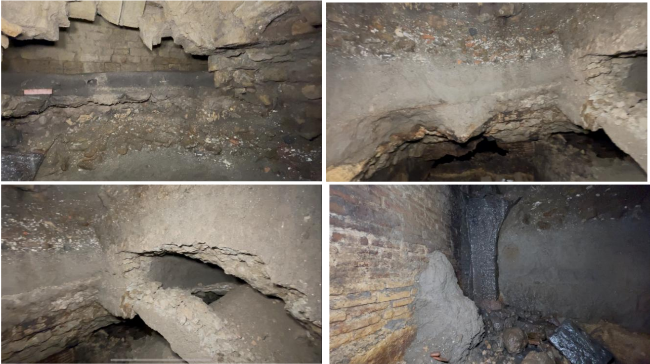
Interno della camera di confluenza sotto la stazione
