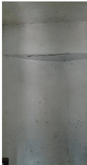
Fessurazioni delle strutture delle vasche
