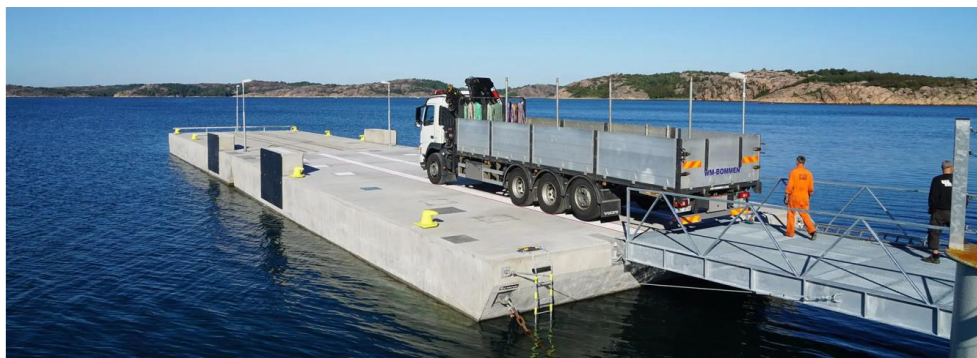
Esempio del complesso pontone - passerella
