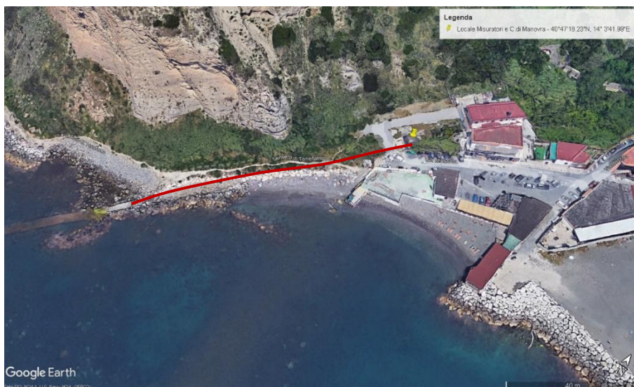
Indicazione del tratto di condotta interessato e della camera di manovra
