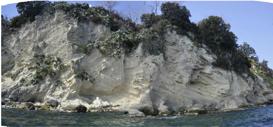
Parete est – Tratto terminale
